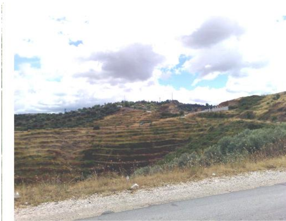
Foto 18. Zhveshja e sipërfaqes së Tokës nga terracat pa sistemet e drenazhimit të ujërave sipërfaqësorë
